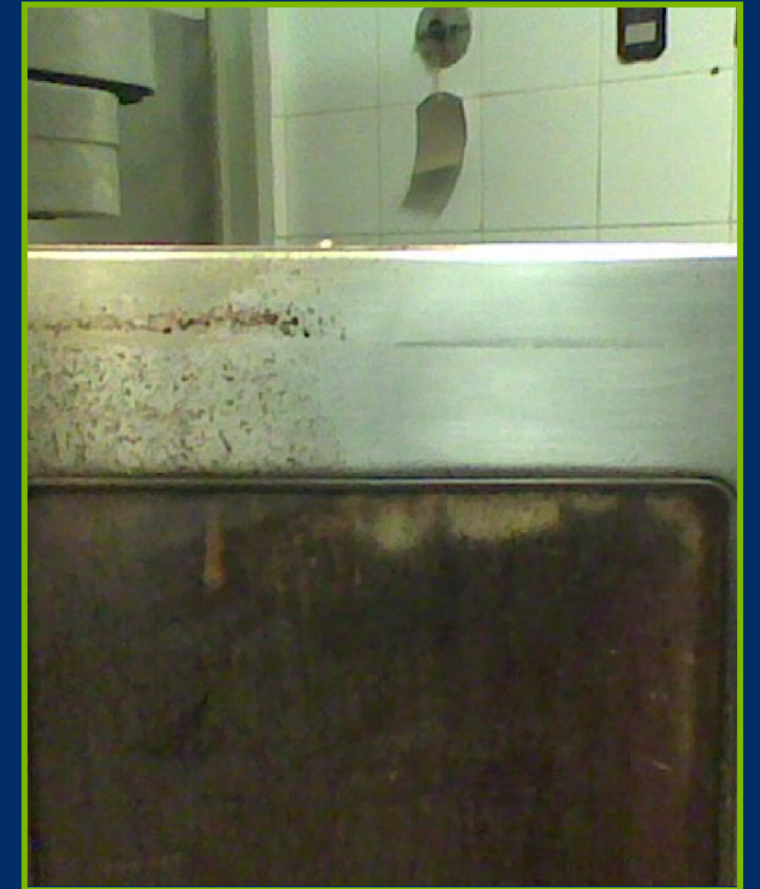
Puerta de un horno industrial (lado interior).
